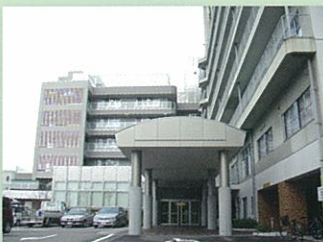
平成15年改修した松原病院
